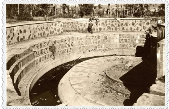
Plateforme de tir du canon de Coucy
